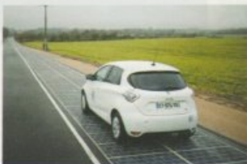
Sonnenenergie auf neuen Wegen: Eine Solarstraße in Frankreich ist Transportweg und Stromlieferant.
